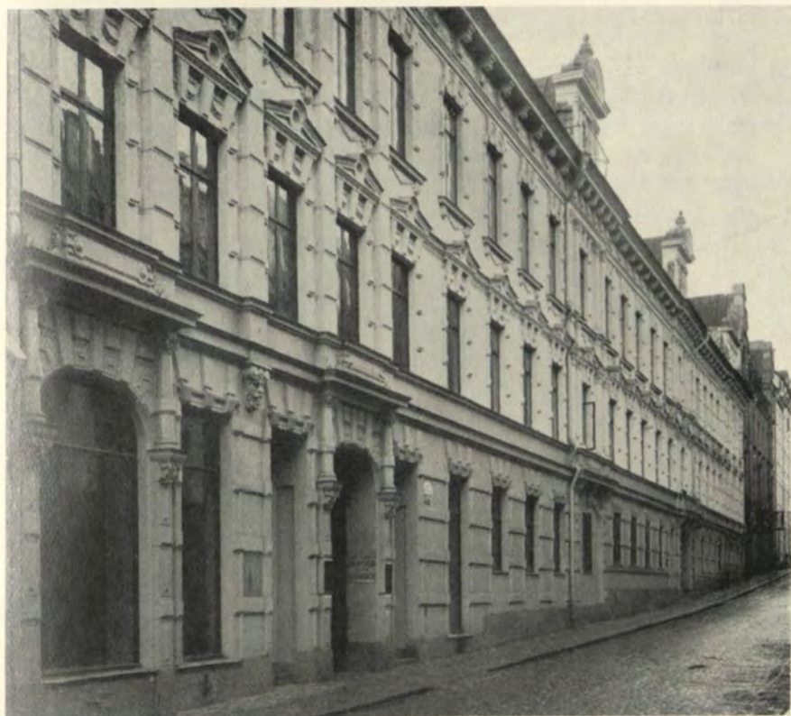
Fastigheten vid Ålandsgatan (Mästersamuelsgatan). Efter ombyggnaden 1882.
